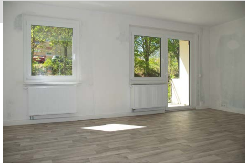
Geräumige Wohnzimmer bieten einen Blick ins Grüne. Die Decken werden tapeziert und weiß gemalt.
