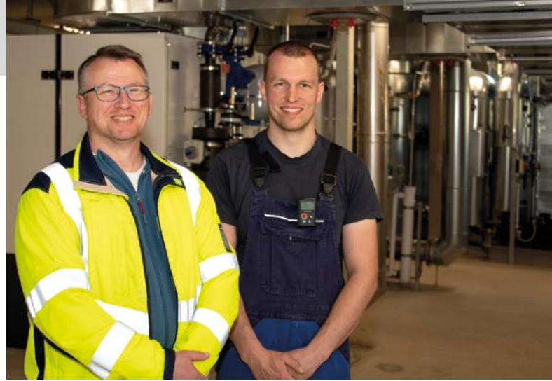
Das aktuell fünfköpfige Team für die Fernwärmeversorgung wird die Wärmewende in Arnstadt in der Praxis begleiten, (v.l.) Ronny Reuter (Abteilungsleiter) und Benjamin Gems.
