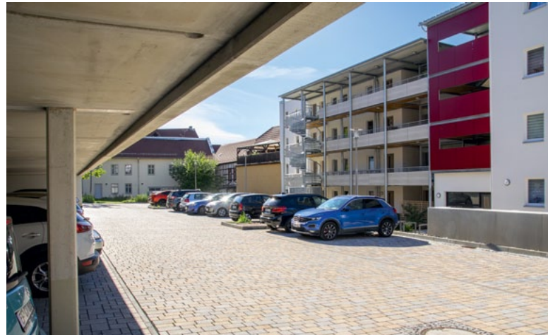
Vom Parkplatz gibt es einen direkten Zugang zum Gebäude Töpfengasse 1.
