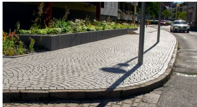
Das neu verlegte Pflaster vor der Töpfengasse 1 erfüllt die Anforderungen zur Barrierefreiheit.
