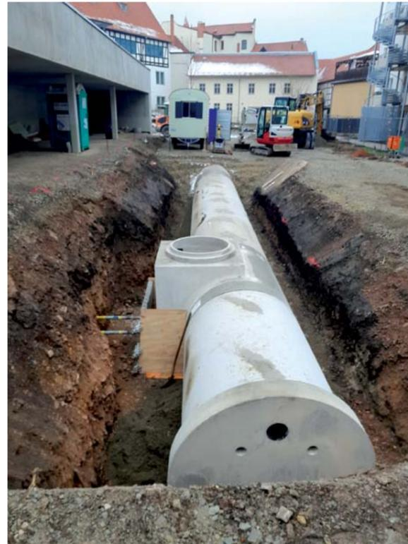
Unter die Fläche des künftigen Parkplatzes wurde ein Rückhaltebecken für Regenwasser mit einer Länge von 45 Metern und einem Innendurchmesser von 1,5 Metern installiert. In diesem Zwischenspeicher können 78 Kubikmeter Regenwasser aufgefangen werden, das nach und nach an das Abwassersystem abgegeben wird. Durch dieses Rückhaltebecken wird vermieden, dass es bei starkem Regen zu einer Überlastung der Abwassersysteme in dem Quartier kommt.
