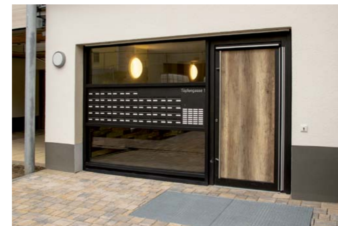
Der neue und barrierefreie Hauseingang mit Briefkasten- und Klingelanlage befindet sich auf der straßenabgewandten Seite.
