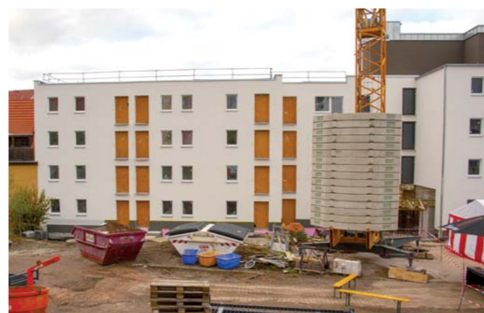
Zum Zeitpunkt des Richtfestes war der Anbau des überdachten Erschließungsganges bereits vorbereitet und sollte in der Folgeweche beginnen. Über diesen Gang werden später die Mieter vom Aufzug zu ihren Wohnungen gelangen.
